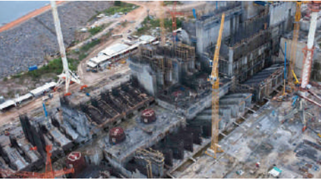
VENEZUELA : TOCOMA HIDROELECTRIC PROJECT (2000 MVA) RIO CARONI PTO. ORDAZ
